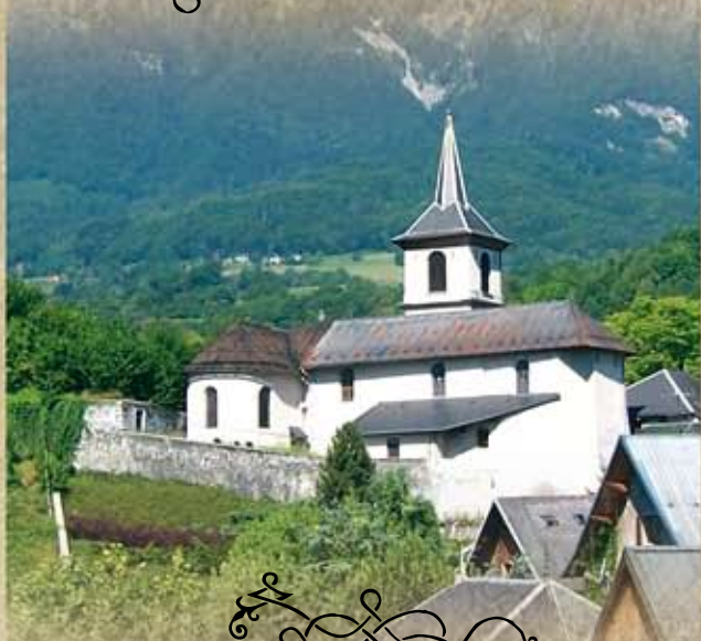
Eglise actuelle (face est) Ce clocher date de 1957.
